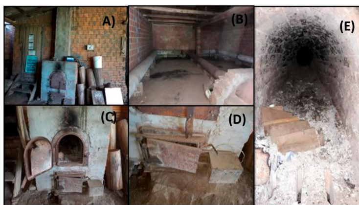
Figura 2. Unidade de cura Convencional (A); área interna da unidade de cura (B); parte externa da fornalha (C); abafador (D); interior da fornalha (E)
